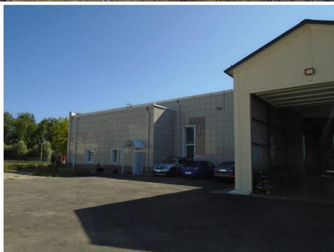
Общий вид здания
