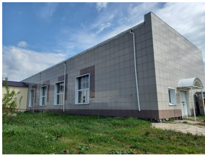
Общий вид здания
