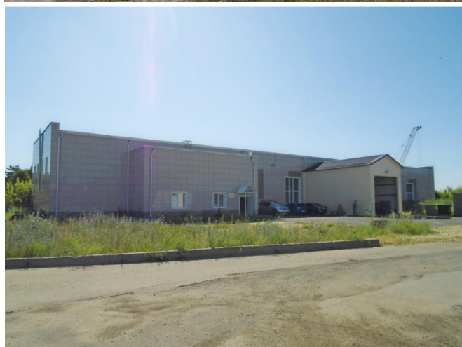
Общий вид здания
