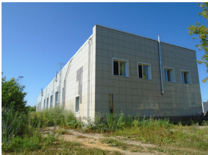
Общий вид здания
